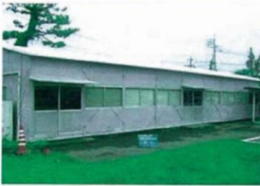
施工現場全景
